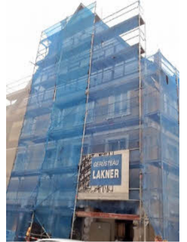
In den vergangenen Wochen wurde das Gebäude renoviert.
